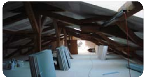
Im Dachstock entstehen Büroräume
