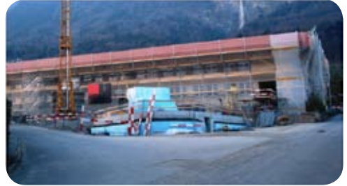
Südansicht der SfHB mit Kulturgüterschutzraum
